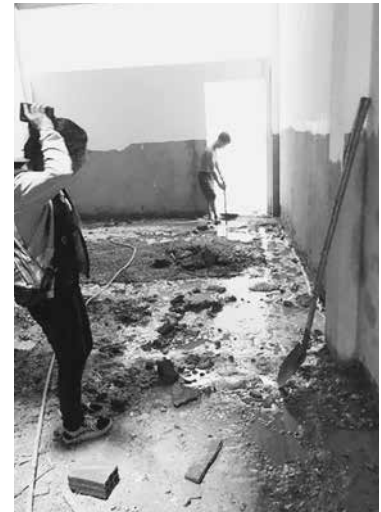
図7 建設現場の様子3
