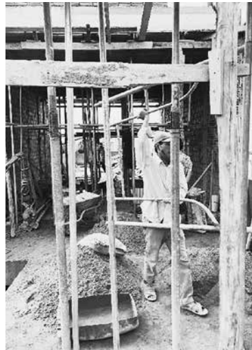
図6 建設現場の様子2
