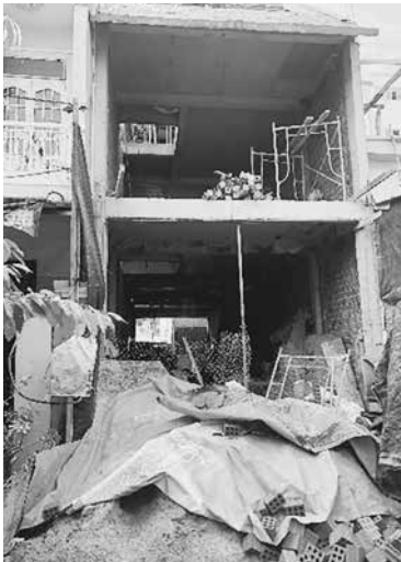
図5 建設現場の様子1
