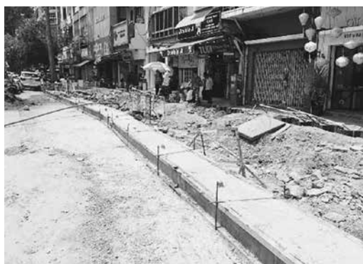
写真1 街中での工事の様子
